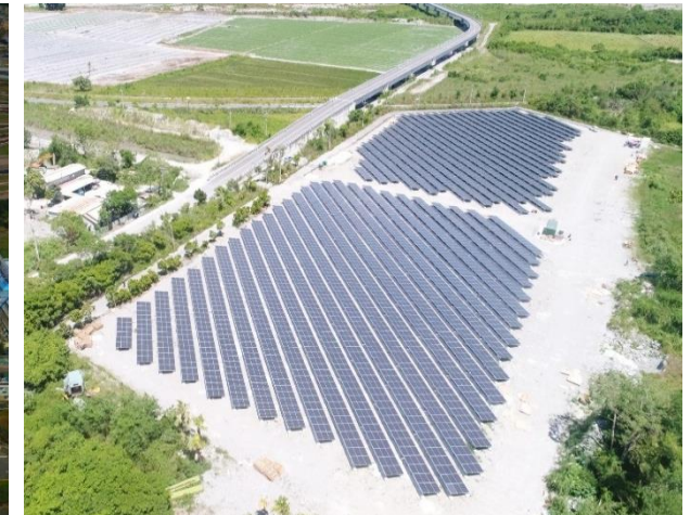
Hualien Fenglin Solar Power Plant
